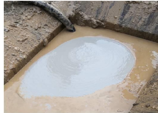
Фото устройства «стены в грунте». ОПР 2019 год
