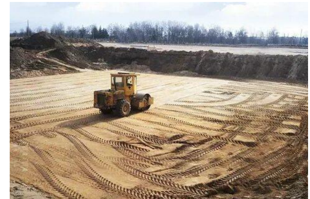
Устройство ПФЭ с применением БЕНТОМИКС®
