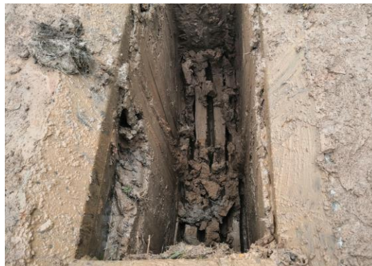
Фото устройства «стены в грунте». ОПР 2019 год
