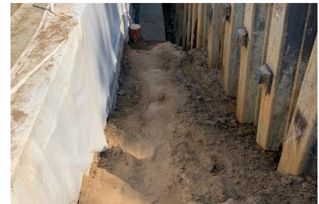
Устройство ПФЗ с применением БЕНТОМИКС®. Рекультивация полигона ПО «Красный Бор»
